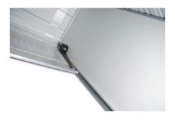
Закрепить ленту стопорного механизма на завершающем профиле (саморезом)
